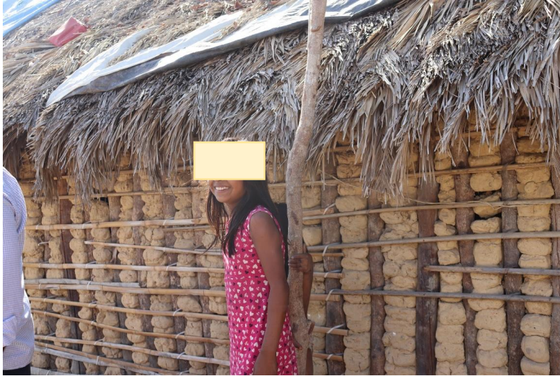
Figura 2: Parte lateral de uma casa
