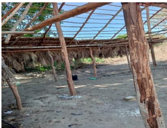
Foto 02 : Construção de moradia
