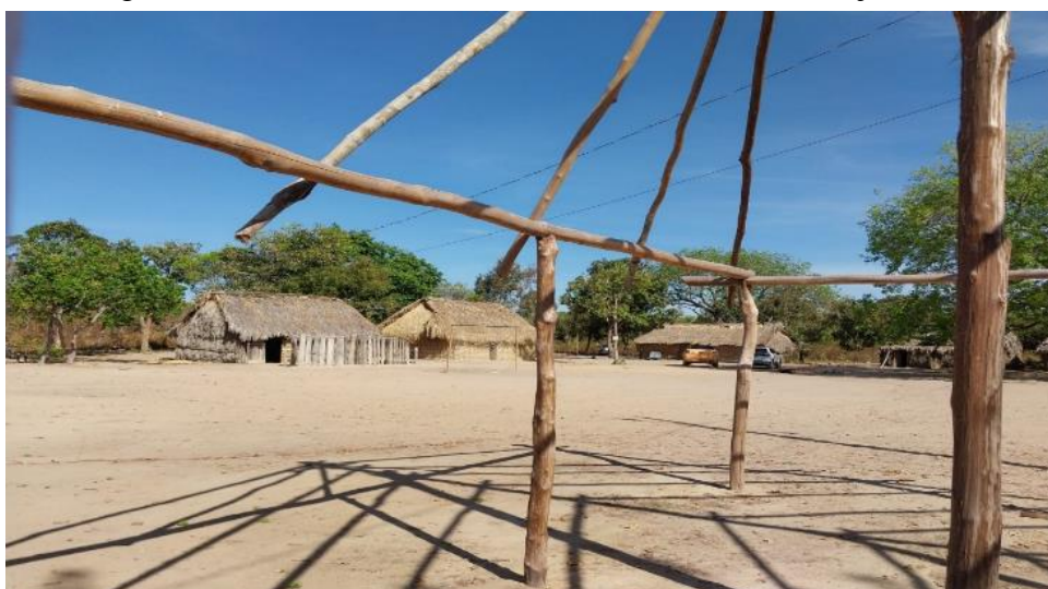
Figura 05: Estrutura inicial de uma casa e outras casas já feitas
