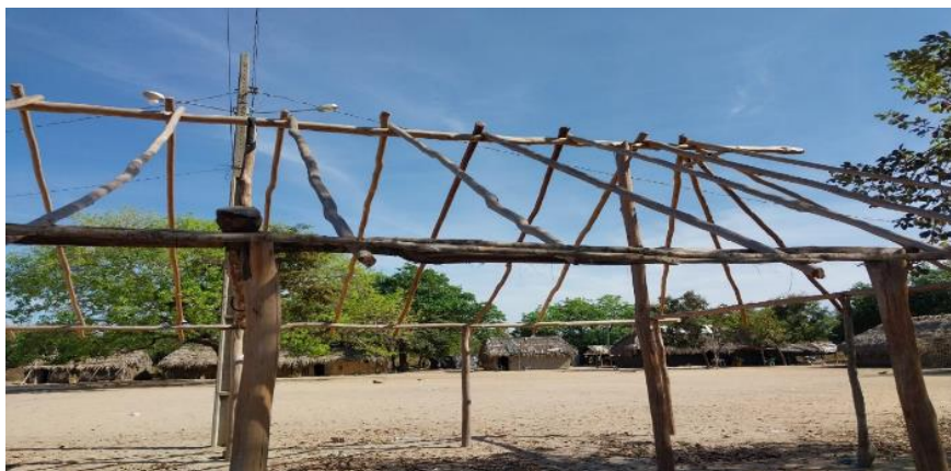
Figura 02: Casa no início da construção.
