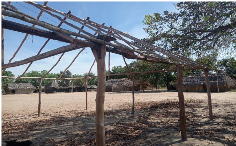
Figura 3: Construção de uma casa no centro terreno
