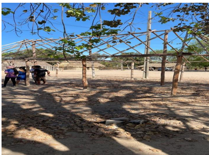
Imagem 01: Construção da moradia
