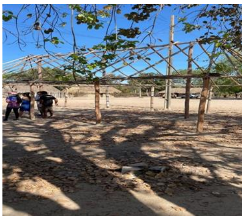
Foto 01 : Construção de moradia
