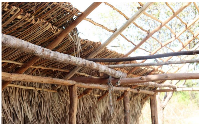
Figura 1: Parte do telhado sendo coberto
